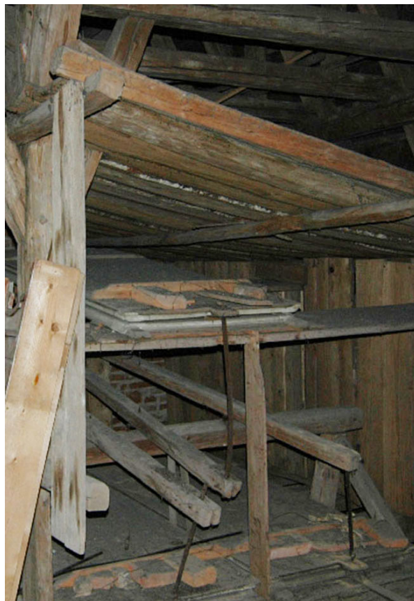
Abbildung 8: Pfarrkirche Kirchdorf am Inn, Reste einer historischen Balganlage (1816) aus der Werkstatt Wippenham
